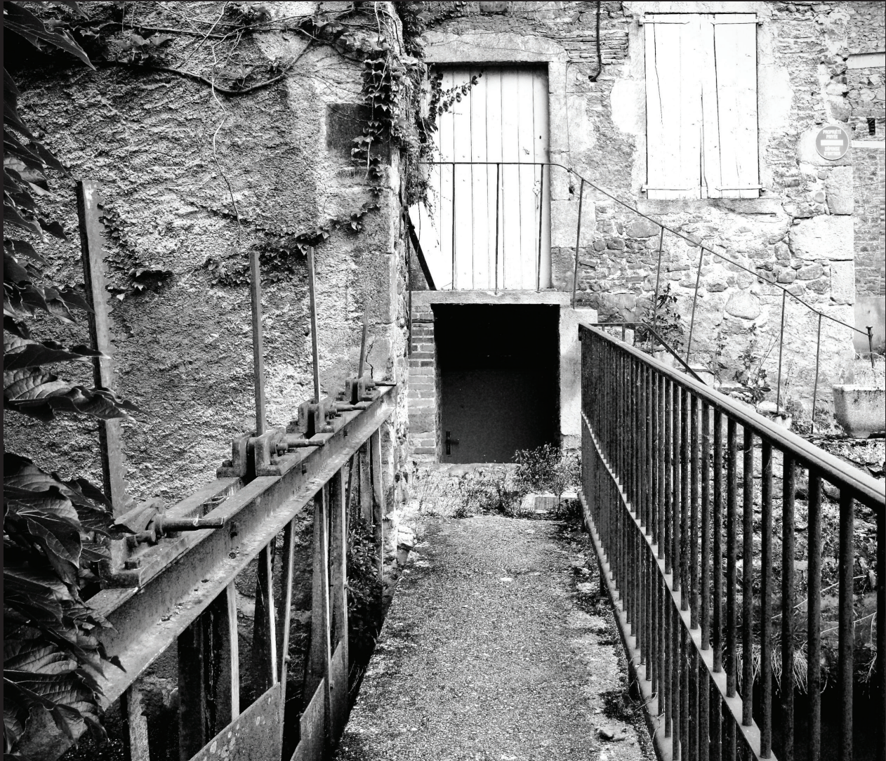
Passerelle avec les crémaillères de commande des vannes Îlot Navaron, Thiers - 2017
